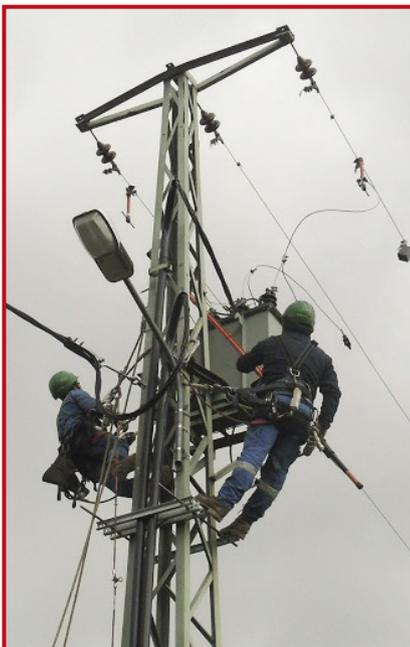
A segurança de pessoas e equipamentos, durante realização de trabalhos na rede de distribuição ou ensaios em instalações elétricas, é garantida pela colocação fora de tensão e pela consignação elétrica das partes da instalação nas quais se vai intervir.
